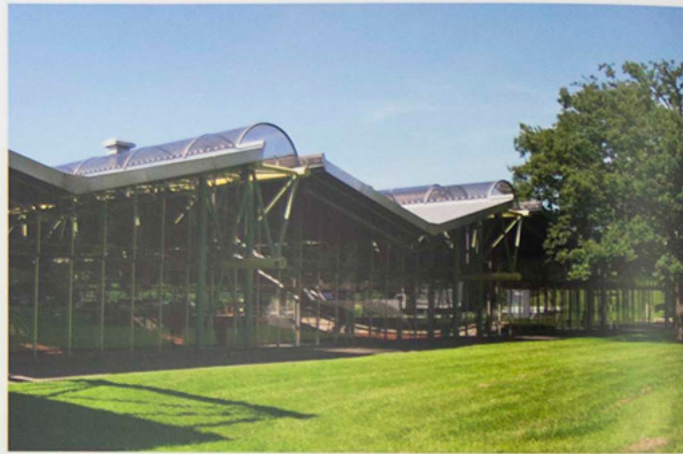
1972 Westseite der Aufwärmhalle West facade of warm-up hall
