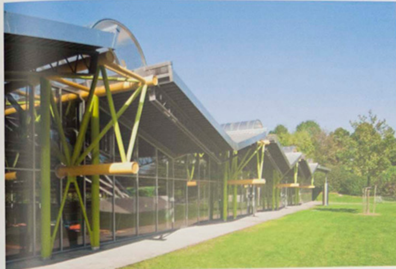
2007 Werner-von-Linde-Halle nach Fassadenrenovierung Werner-von-Linde-Halle after facade renewal
